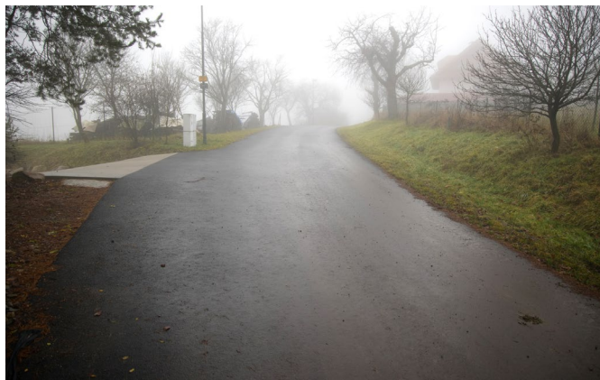
V Řetechově se opravila další část komunikace
