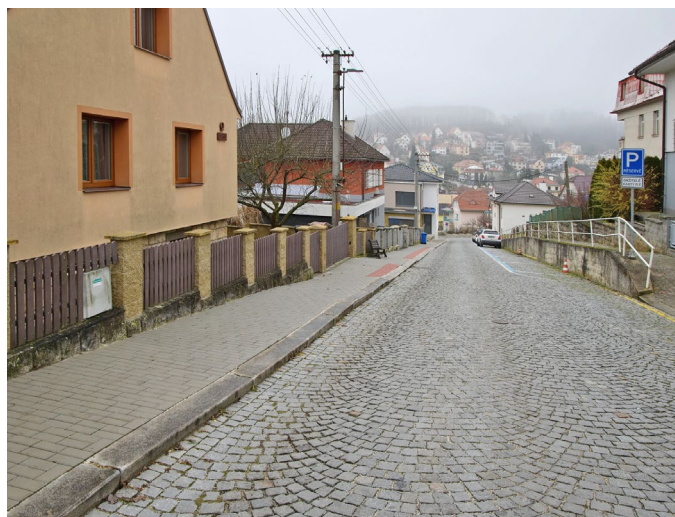
Nové chodníky na ulici Rumunská
