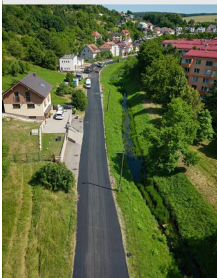
Foto během realizace rekonstrukce
