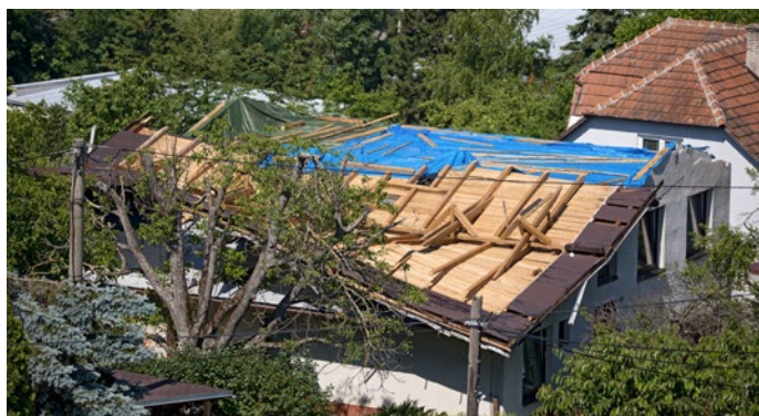
Střecha rodinného domu
