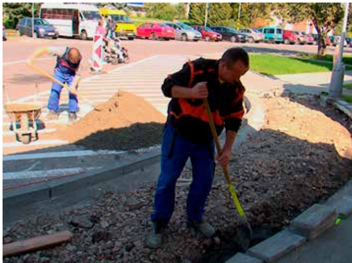
Na přelomu září a října se Technické služby Luhačovice pustily do opravy chodníku v ulici Nádražní. Opravy se týkají
