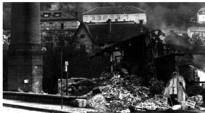
Zboření staré elektrárny v místě Elektry, 1964
