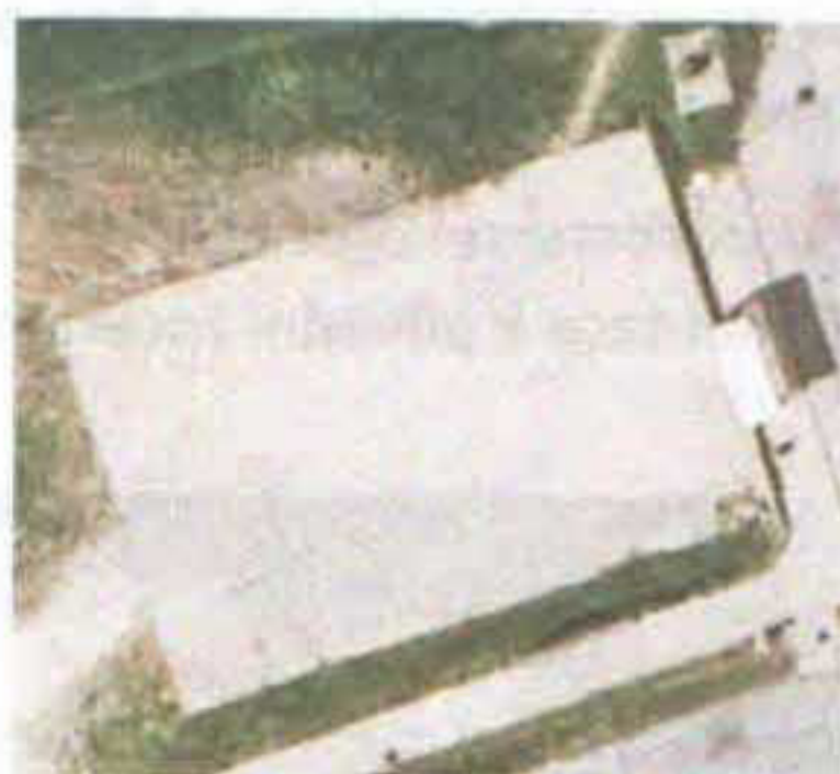
Obr. 2 – stav před rekonstrukcí
