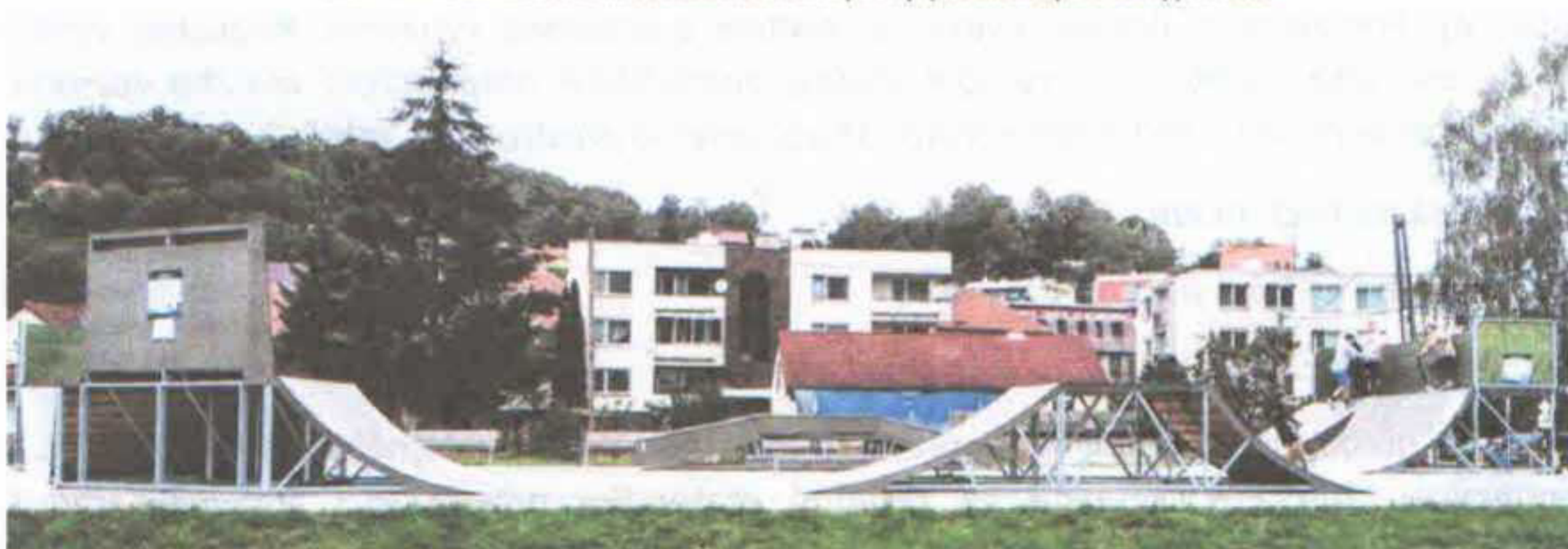
Obr. 5 – hřiště po provedené rekonstrukci vč. instalovaných herních prvků
