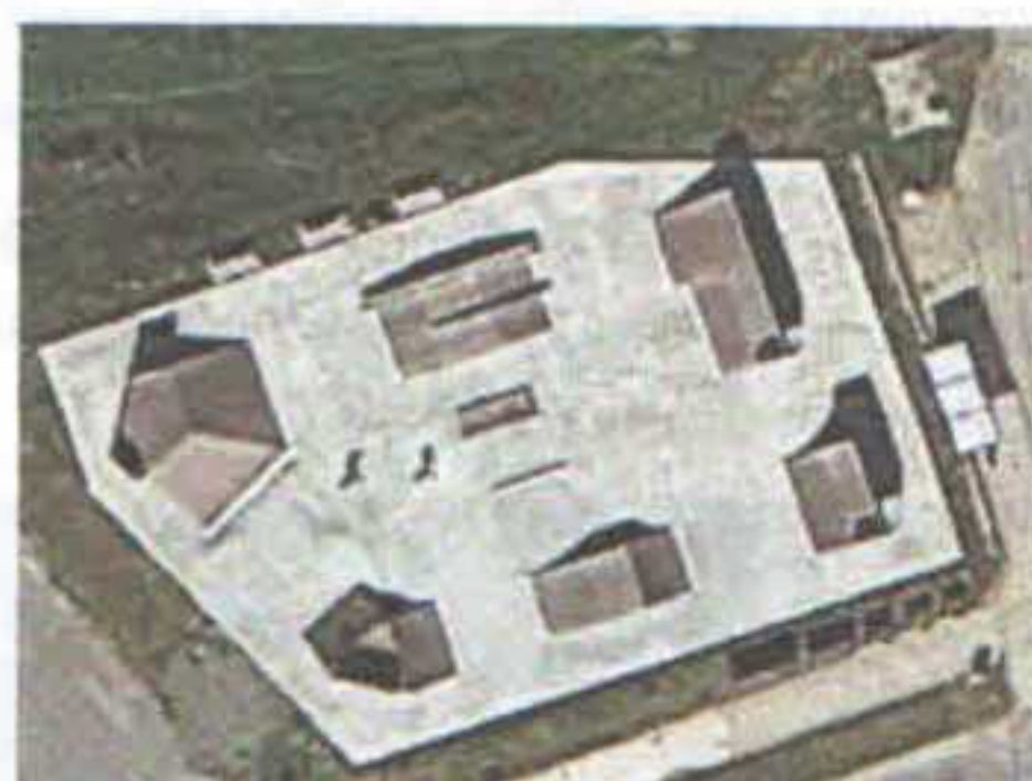
Obr. 3 – stav po rekonstrukci
