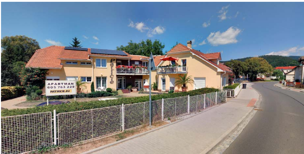
Obr. 5 příklad nevhodných staveb pro ubytování a penziony s počtem bytů více než 2 v plochách BI bydlení individuálního (zdroj: Mapy.com)
